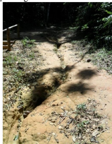
Figura 3. Formação de ravina ao lado de escada construída próxima ao primeiro ponto de coleta evidenciado concentração do escoamento de água na trilha. Foto: L. A. Rangel, 2012.
